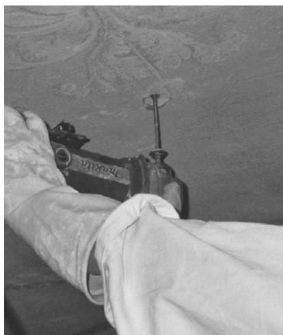
Fig. 17 – Inserimento del perno
